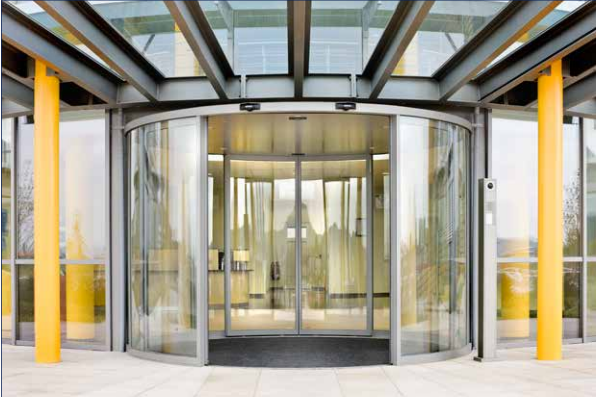
CEMAG Anlagenbau, Hameln, Germany (Photo: Lothar Wels)
